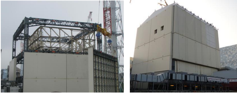
Şekil 11. İnşaatı devam eden kaplama binası (1. ünitenin etrafında)
