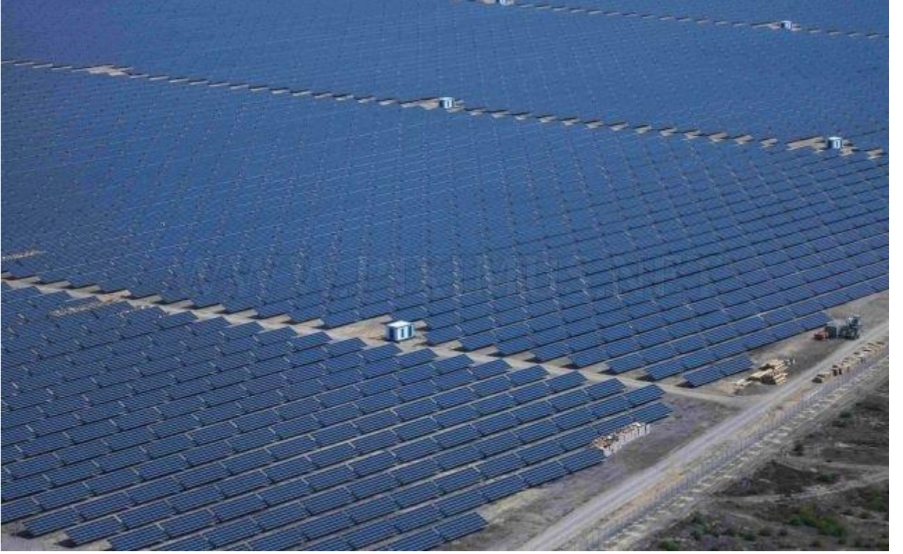
71 megawatt kapasiteli Lieberose Güneş Enerjisi Santrali GES üniteleri Berlin – Almanya
