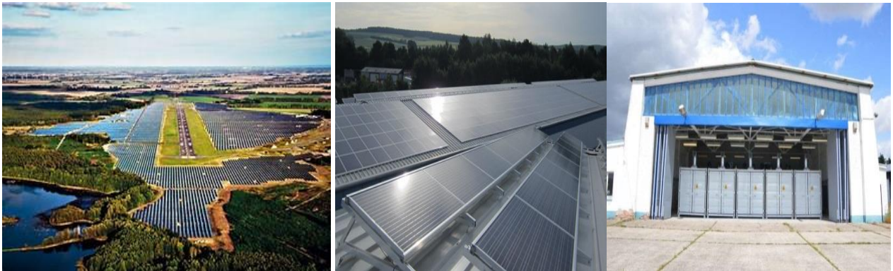
Şekil 4: Berlin'in 30 km yakınındaki Neuhardenberg Solar Parkı, kullanılan paneller ve enerji depolama akülerinin bulunduğu bina
