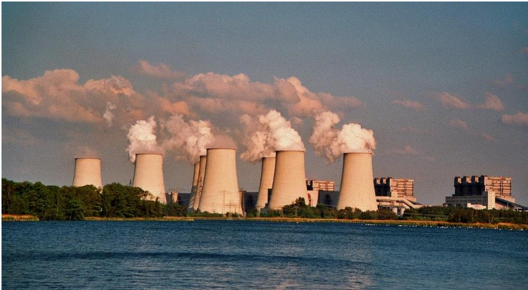
Jaenschwalde elektrik santrali / Almanya Brandenburg. Santralde linyit ve çöp yakılıyor
