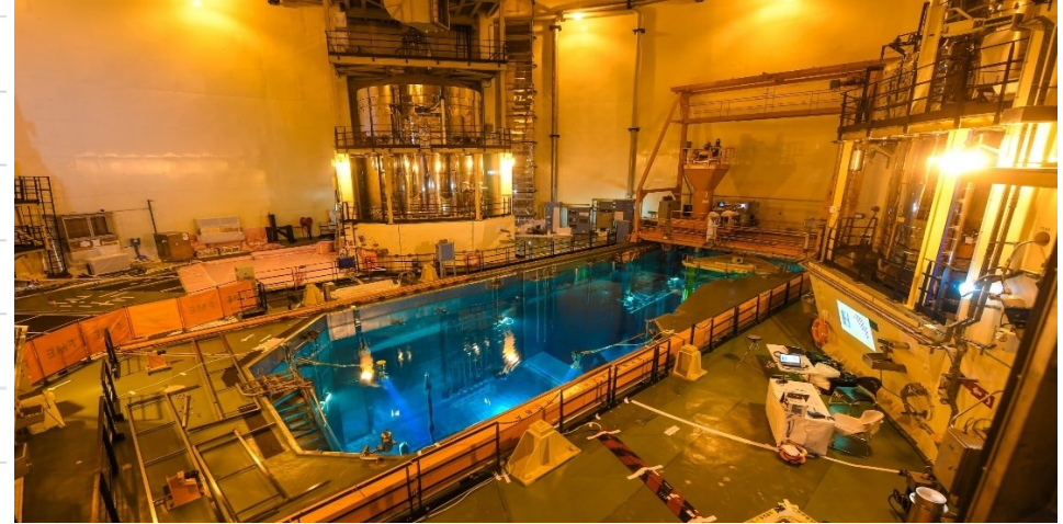
Şekil 7: Çin Dayawan Nükleer reaktöründeki kullanılmış uranyum yakıt elemanları havuzu (2019), Kaynak: Xinhua/Getty
