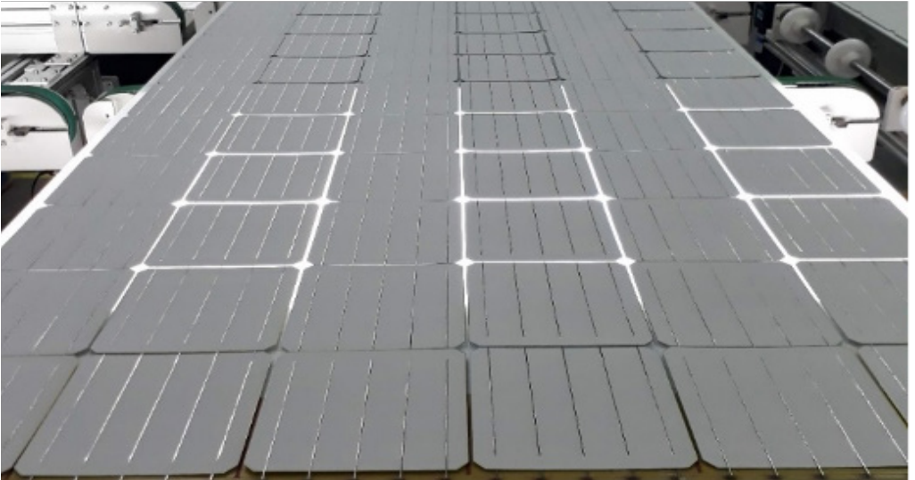
Şekil 3.7. Panel dizilim görsel kontrol
