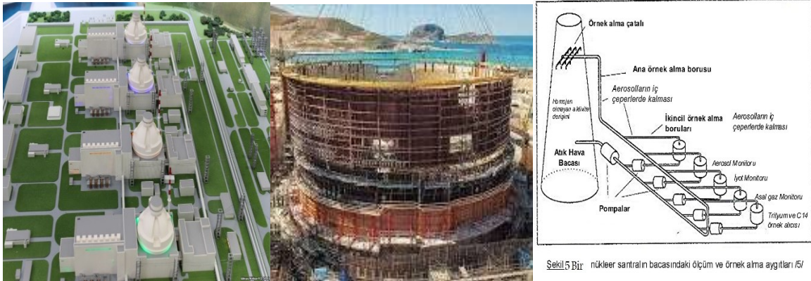
4 reaktörlü Akkuyu Nükleer santrali maketi, bir reaktör binasının yapımı ve baca gaz akışını temsil izokinetik örnek alma düzeneği
